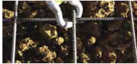
Kit d'ancrage composé de 3 cables en acier galvanisé avec un système de mamille pour arrimer l'arbre sur le treillis soudé en fond de fosse. Adapté à tout types de circonférence et hauteur.
