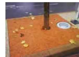
PERMEO est une particule de bois issue de rondins de Résineux durs déchiquetés, broyés, calibrés et tamisés qui en mélange avec du ciment permet de réaliser des entourages d'arbres drainants.
